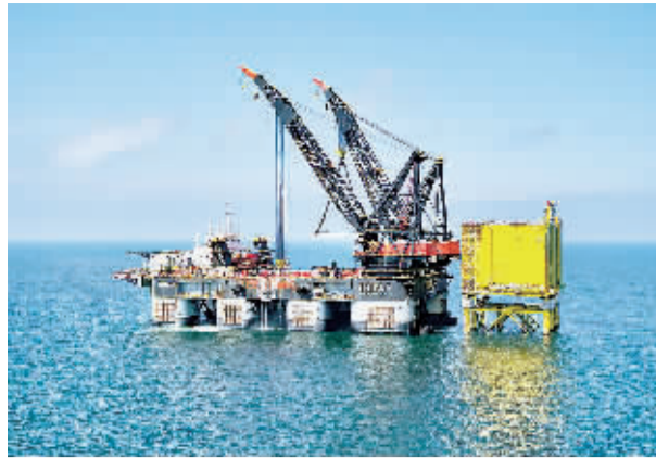
ABB集团近日在位于大西洋边缘北海的海上平台上安装了全球电压最高和装机容量最大的海上换流站,该320千伏换流站的输电容量为800兆瓦,在全世界同类换流站中首屈一指。 本报记者 陈 颀供稿
