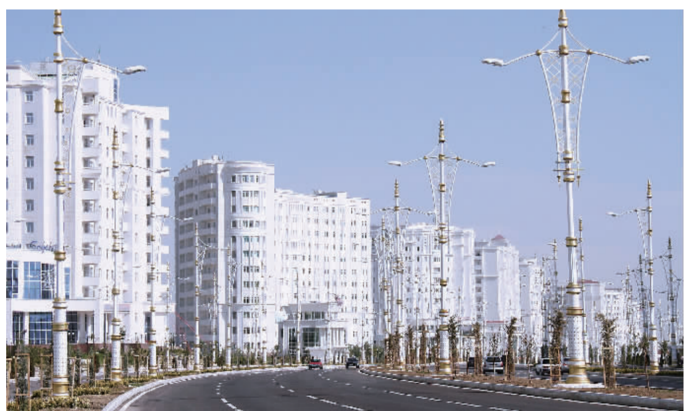
土库曼斯坦约有80%的国土被沙漠覆盖,常年强烈的日照、风沙和干旱对建筑物损害严重。为解决这个问题,近年来新建的楼房均用白色大理石贴面。据统计,在首都阿什哈巴德约22平方公里的土地上,新建的543座楼房共使用超过450万平方米的白色大理石贴面,使得阿什哈巴德为拥有白色大理石贴面而建筑最密集的城市入选吉尼斯世界纪录。(新华社发)
