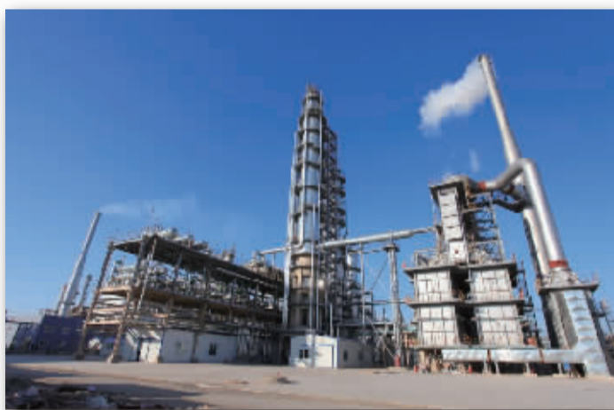
盘锦北方沥青燃料有限公司的二期工程之一，200万吨重交道路沥青生产装置平稳运行当中。这道炼油的首道工序的正常运行，将为企业接下来的60万吨催化裂化装置的生产提供充足的原料供应，增加宝来集团的原油加工能力。
