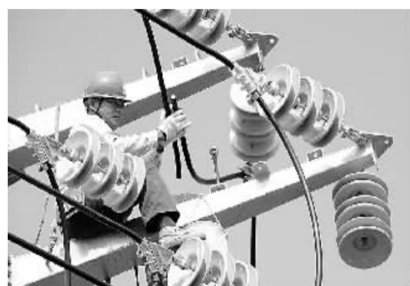
江苏省泰州市姜堰开发区电力施工人员正在对该区黄村变20千伏开发区四回线路进行扩容和改造。此项工程是该区今年配电网重点工程之一。
