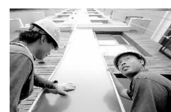
8月21日，北京海淀区辛店安置房项目工地，海林节能设备股份有限公司工人正在安装壁挂平板太阳能热水器。海淀区已有近万套安置房项目采用这种节能环保的“太阳能阳台”，这也是北京在保障房项目中首次大面积应用太阳能集热系统。
