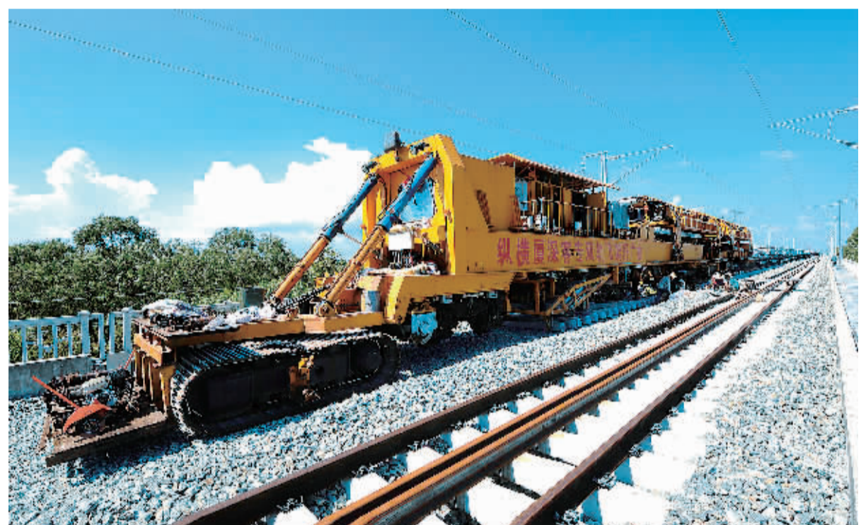
施工人员在厦深铁路陆丰段用大型架桥机械铺设轨道(8月10日摄)。 8月10日23时,中铁十一局三公司完成厦(门)深(圳)铁路广东段右线最后一节500米长轨铺设任务,厦深铁路全线长轨双轨贯通,结束了我国东南沿海地区没有沿海铁路的历史。厦深铁路东起厦门市,西到深圳市,全长502公里,设计时速200公里,总投资约417亿元。该线通车后,乘车从厦门至深圳的时间将由11小时缩短至2.5小时。 新华社记者 郝向前摄
