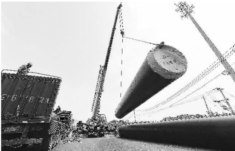
8月7日,大型机械在辽宁朝阳燕山湖发电公司2×600兆瓦机组供热改造工程外网管建设现场吊装供热管道。东北在建最大的发电厂——辽宁朝阳燕山湖发电厂2×600兆瓦机组集中供热工程进入全面施工阶段,300余名施工人员和50余台大型机械奋战在施工一线。白铁军摄(新华社发)
