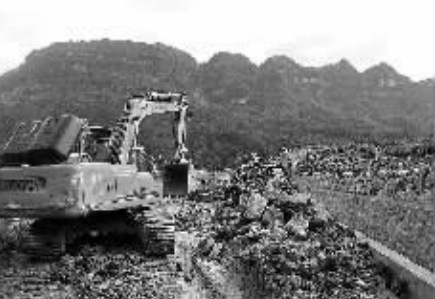
“丹治二期”工程把坡耕地变为耕地，防止水土流失。图为陕西省汉中市宁强县成家湾村陈家湾工程施工现场。
