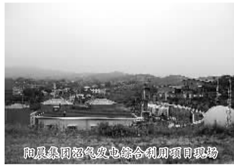
阳晨集团沼气发电综合利用项目现场
