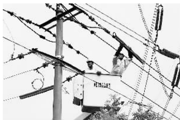
7月28日,国网山东高密市供电公司检修(建设)工区检修人员头顶烈日对10千伏户内和线实施带电作业。带电作业是该公司实施减少停电的一项技术措施,可以提高电网运行水平,实现增供扩销。孙佳摄
