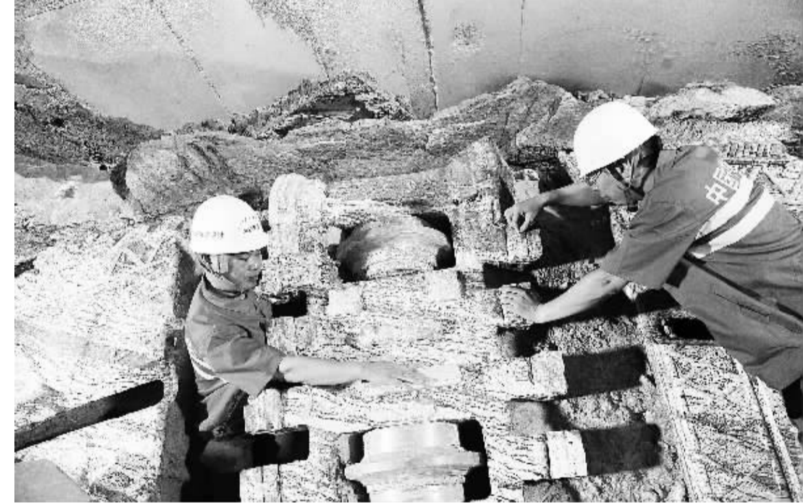
7月26日,中铁隧道集团工人在北京站至北京西站铁路地下直径线盾构隧道检查刀盘刀具磨损情况。本报记者 赵 晶摄
