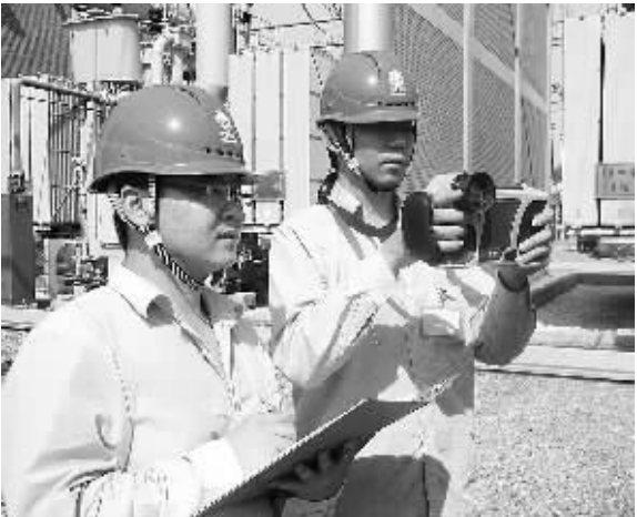
随着气温不断攀升，郑州地区供电负荷持续走高，为确保大负荷下设备的安全可靠运行，郑州供电公司运行人员加大对设备巡视力度。图为该公司员工正在对主变进行红外测温。
