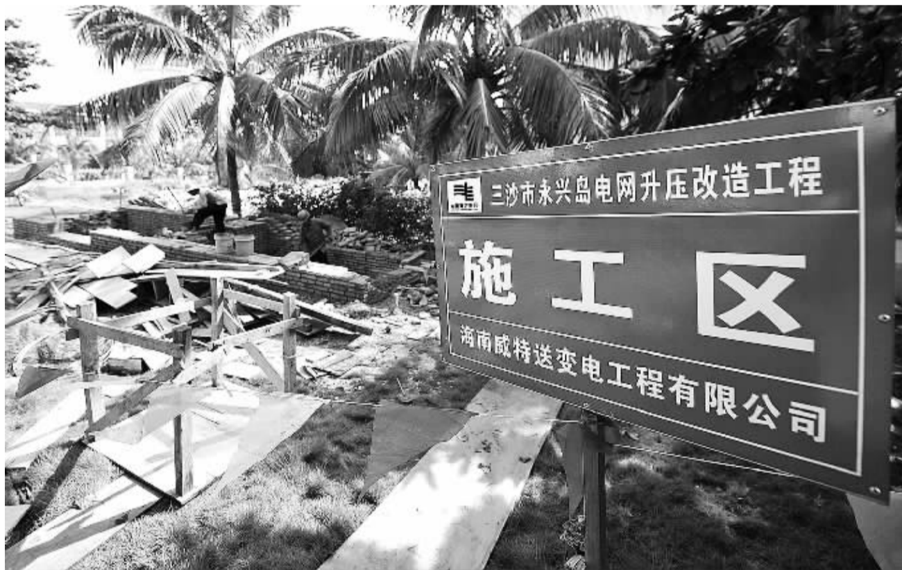
这是三沙市永兴岛电网升压改造工程施工工地（7月7日摄）。三沙市成立近一年来，各项基础设施建设进展顺利，污水处理厂一期工程、海水淡化设施等已投入使用，电网升级改造、西沙人民医院等工程建设也在有序推进。新华社记者 郭程摄
