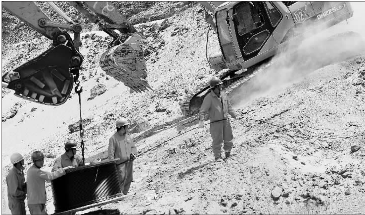
和田河气田产能扩建项目地面建设工程正在紧张施工中,建成后日处理天然气能力将达600万立方米。
