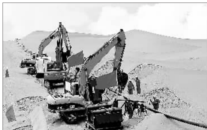
参建的辽河一建公司在铺设管道。管道将穿越沙漠,与塔里木油田已建管道连通,使南疆五地州42个县(市)逐步实现气化。
