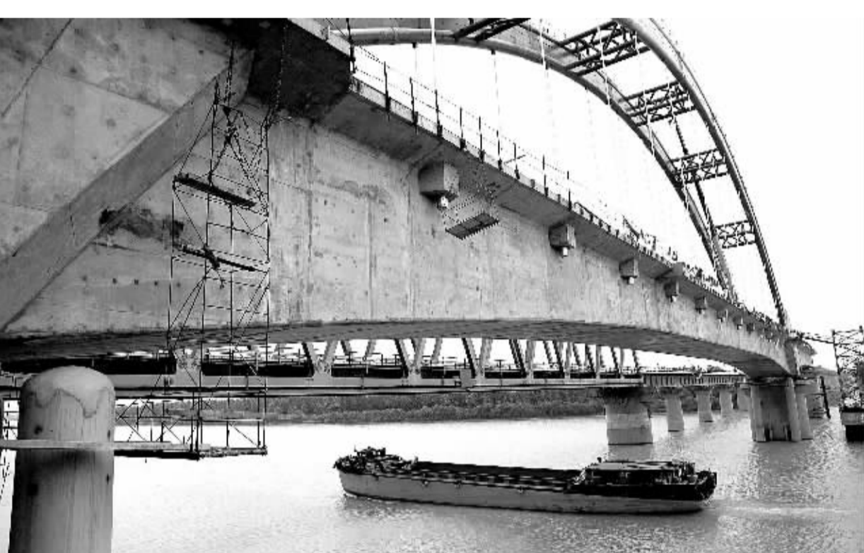
这是7月4日在扬州拍摄的宁启铁路复线京杭运河特大桥。当日,宁启铁路复线电气化改造最后一个控制性工程——跨京杭运河特大桥主体正式完工。该桥长1671.69米,其中主跨114米,是整个复线电气化改造工程中跨度最长的桥梁。 张丙涛摄(新华社发)
