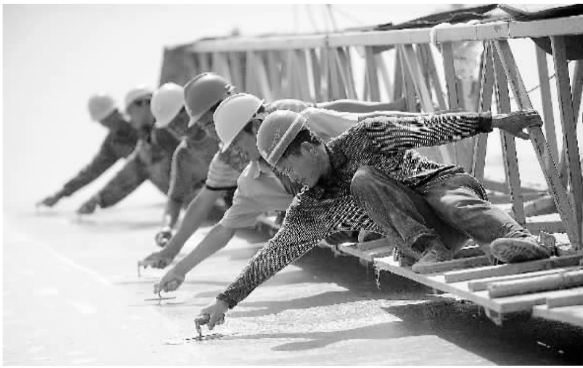
6月27日，中铁十三局六公司工人在南水北调中线干线工程浙川段施工。施工方克服点多线长、膨胀土改良等技术难题，创下了中线工程跨度第一、流量第一、单跨重量第一等佳绩。目前施工进度顺利，预计9月底主体工程完工。
