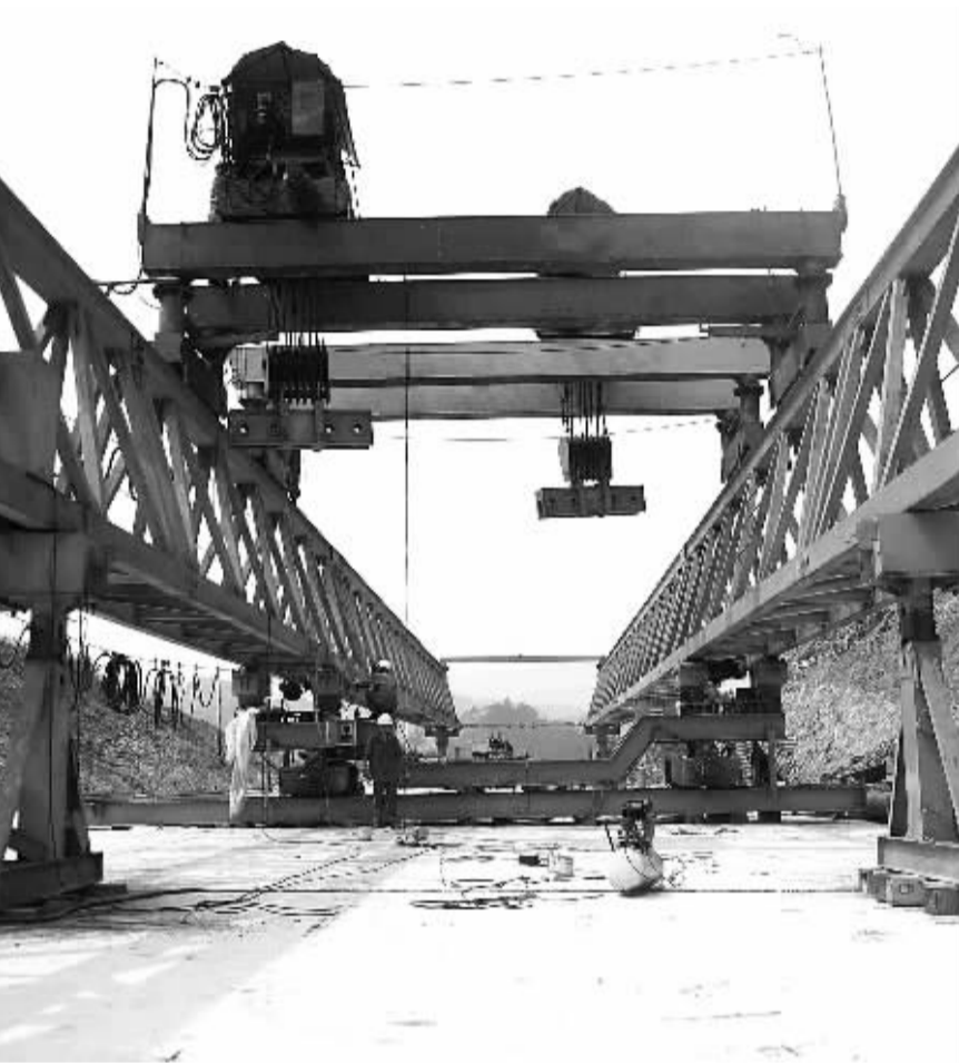
工人在架设三江至柳州高速路的跨山铺路钢架。时下,广西三江至柳州的高速公路建设正在紧张进行,这条高速公路是广西“四纵六横三支线”高速公路网的重要组成部分。建成后三江至柳州仅需2小时车程,比原来缩短一半。新华社记者 张爱林摄
