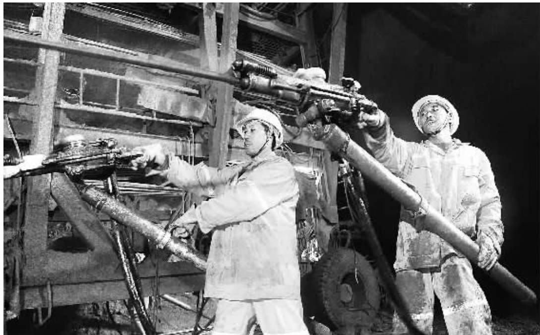
6月24日,山西中南部铁路通道隰县隧道贯通。中南铁路是我国首条高等级重载铁路,西起山西吕梁,东至山东日照港,建成后打通山西中南部,成为晋煤外运的重要通道。隰县隧道全长10512米,贯通后还将进行加固坑道、铺设管线等工作。因为工人在隧道内进行最后一钻钻爆法施工。
