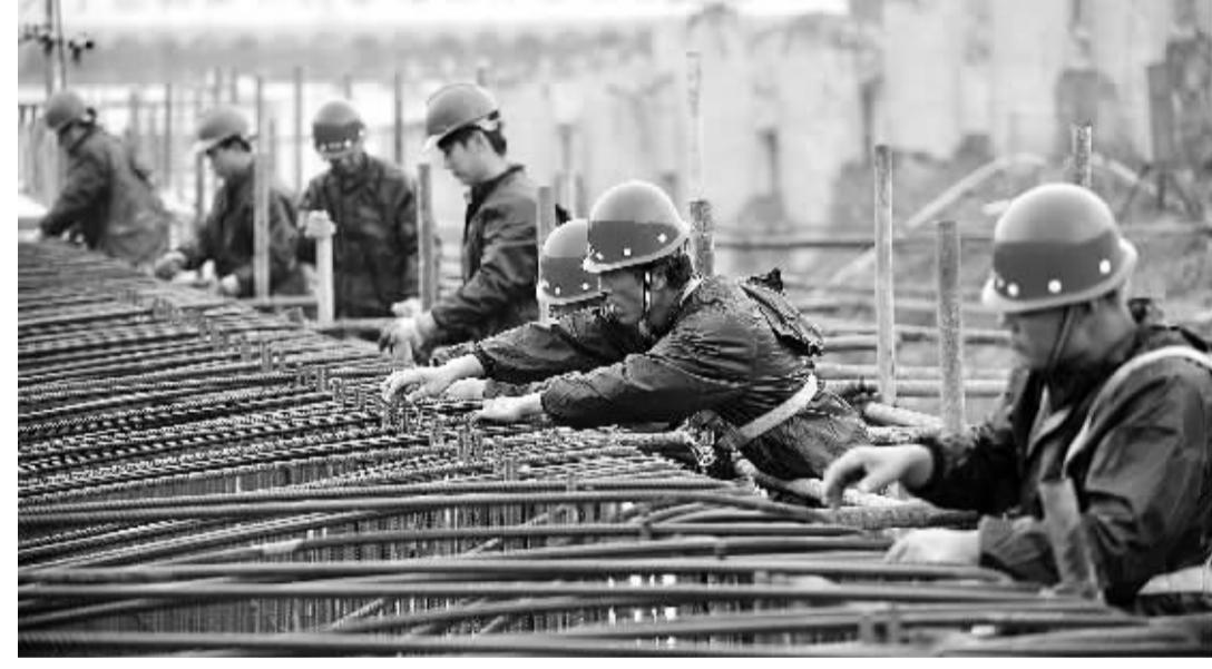
6月22日，工人冒着细雨在工地现场绑扎钢筋。南水北调天津干线TJ4-5标段位于河北省廊坊市安次区境内，全长9.148公里。该工程于2012年1月正式开工，目前已完成绝大部分主体混凝土工程建设任务，剩余主体浇筑任务预计6月底完工，实现标段内全线贯通。
