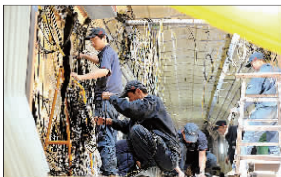
CRH380CL型车布线工序施工现场，员工以“一点也不差，差一点也不行”的工作精神，确保车辆安全运行。
