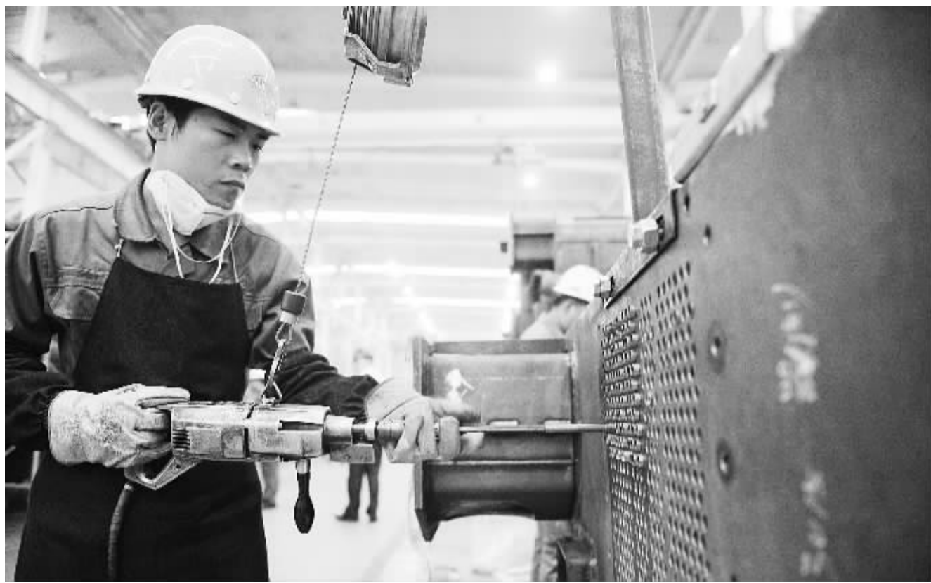
6月7日，在河北省廊坊市开发区同方川崎空调设备公司，工人在生产作业。日前，位于河北廊坊市开发区的同方川崎“国家级吸收式热泵产业化示范项目”二期竣工，与一期项目一起，可实现年产吸收式热泵1650兆瓦，产值近4亿元，成为国内最大的吸收式热泵研发基地。
