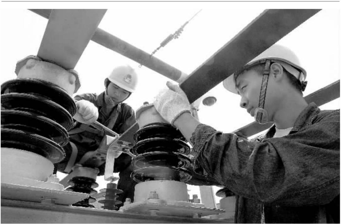
6月3日,国家电网山东莒南县供电公司员工为变电站10千伏出线安装避雷器。入夏以来,国家电网山东莒南县供电公司全面排查电网安全隐患,全面保障社会夏季用电。胡顺刚摄(新华社发)
