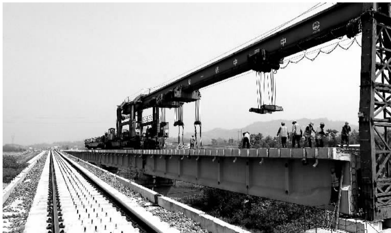
5月21日,中铁一局兰渝铁路铺架队的工作人员在四川省华莹市阳和镇用架桥机铺架祝家坝特大桥左线桥梁。目前,兰(兰州)渝(重庆)铁路工程架桥、铺轨工作最后7公里线路——四川省华莹市境内祝家坝特大桥高兴站工程正在进行施工,预计6月30日前兰渝铁路与襄(襄樊)渝(重庆)铁路接轨。
