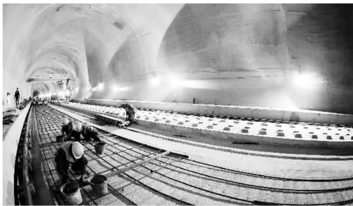
4月26日, 由中国铁建十六局承建的贵广铁路无砟轨道首件工程现场, 施工人员正在进行双块式无砟轨道底层钢筋绑扎。据了解, 贵广铁路建成后, 全程乘车时间将由现在的22个小时缩短至4个小时左右。
