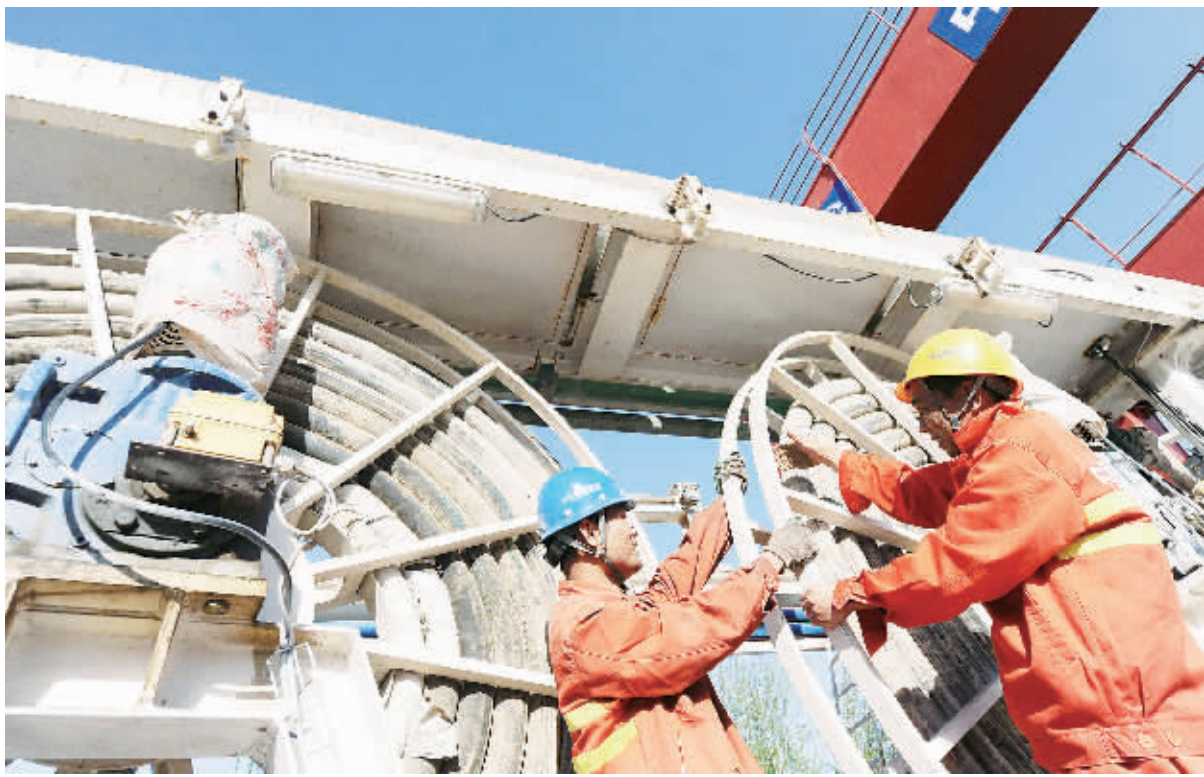
4月25日,中铁隧道集团职工在北京市南水北调配套工程东干渠段对盾构机设备进行调试。当日,该段盾构机调试工作完成,将始发掘进。据介绍,北京市南水北调配套工程东干渠段工程穿越亮马河、东北环铁路等风险源,计划2014年9月30日贯通。东干渠工程是北京市南水北调配套工程的重要组成部分,是保证北京市中心城区和新城主要水厂具备双水源供水的重要条件。
