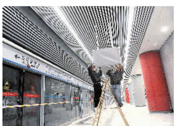
4月2日,北京地铁10号线二期站台,工作人员装修装饰站台。目前,10号线二期环线设备安装及装修工作基本完成。5月初10号线将实现环线运营,成为继2号线之后北京第二条环线地铁。本报记者 赵晶摄
