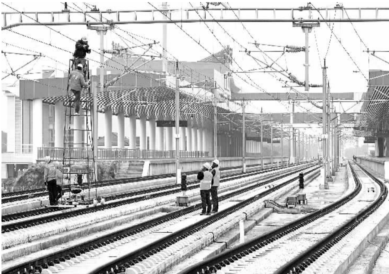
工人在杭甬高铁上虞北站检查高铁电气化接触网。2月25日,国家重点工程——杭甬高铁全线电气化接触网一次性送电成功,标志着这条连接浙江省杭州市与宁波市的高速铁路建设即将进入通车运营前的联调联试阶段。
