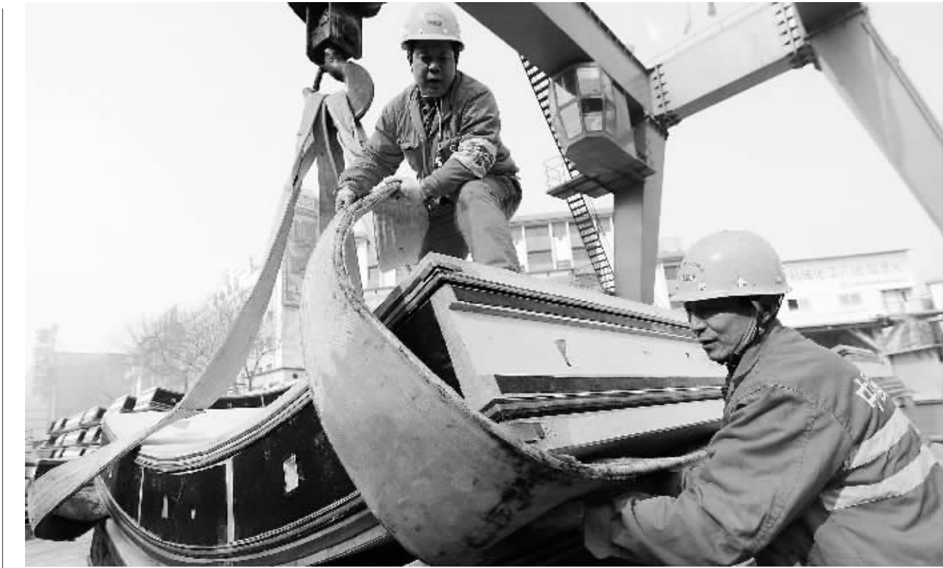
春节假期刚过,中铁隧道集团重点工程项目——北京地下直径线工程施工现场一片忙碌。目前,该工程施工进度处在通过中国铁道博物馆正阳门馆风险点的关键时期,建设者们放弃节日休假,坚守岗位,确保工程建设安全顺利。图为中铁隧道集团建设者正在进行吊装管片作业。
