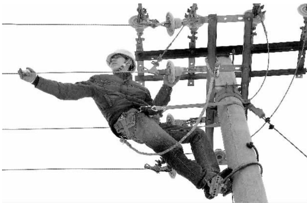
2月13日,山东滨州市富国供电所职工正在抢修供电线路,保障辖区内居民春节期间的安全用电。
