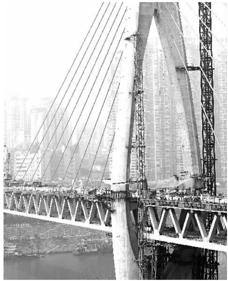
这是2月5日拍摄的重庆东水门长江大桥。2月4日,连接长江南北两岸的重庆东水门长江大桥最后一根钢梁吊装就位,标志着大桥桥梁主体正式合龙。周 会摄(新华社发)
