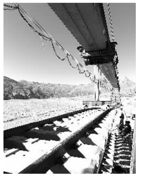
1月16日，中铁八局工程技术人员在西藏曲水县境内铺轨。
