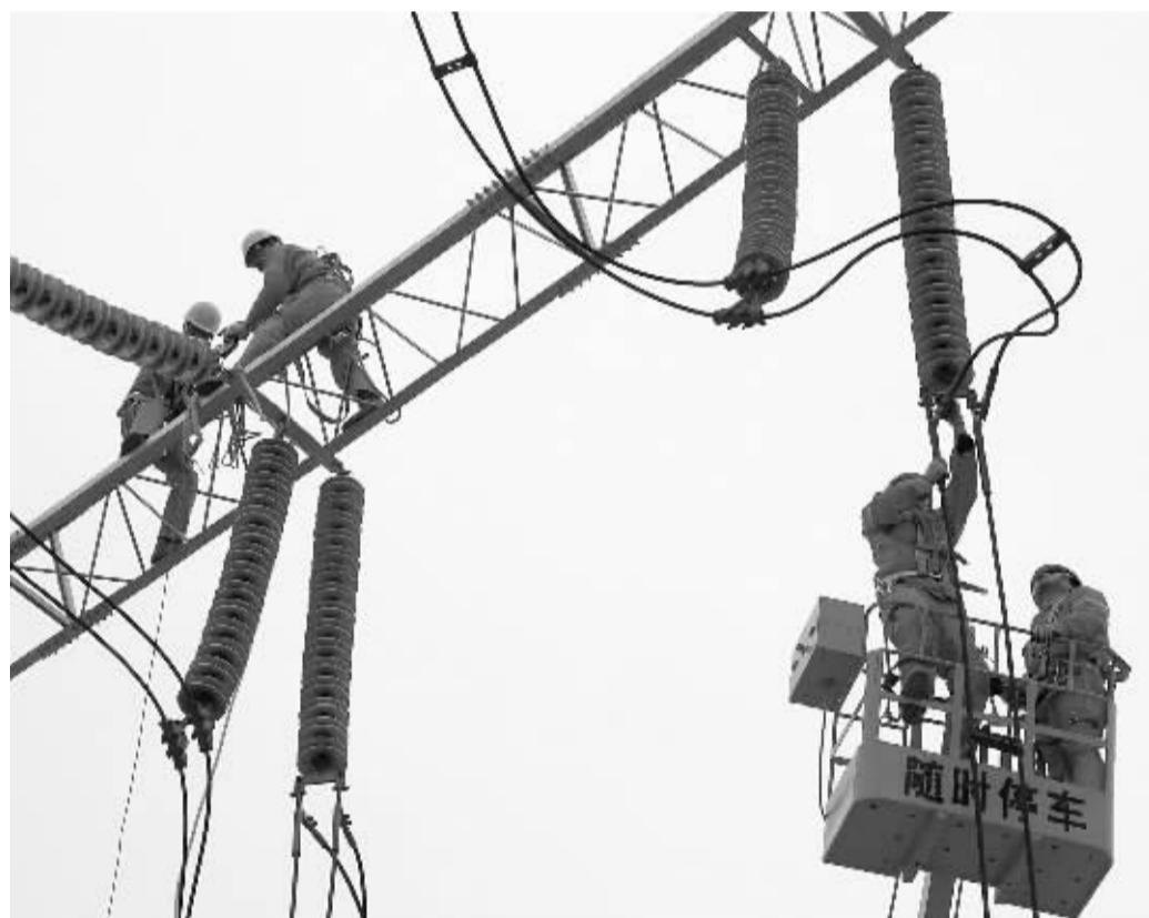
1月11日,大同供电公司变电检修员工正在大同市220KV官堡变电站对设备绝缘子进行更换维护工作。结合山西省近期召开的全省安全生产紧急电视电话会议精神,公司紧密结合工作安全生产工作实际,严格落实保证安全的各项措施,确保广大客户和百姓春节期间生产生活用电平稳有序。
