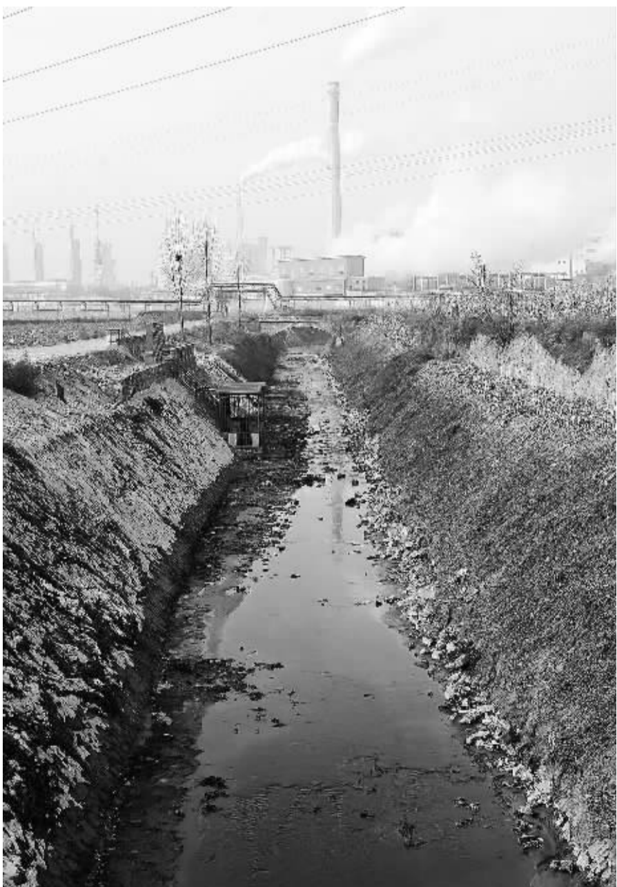
这是山西潞安天脊“12·31”苯胺泄漏事故发生的排污渠。
