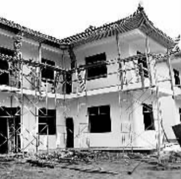
2012年12月9日,施工人员在湖北宣恩县水田坝村装修即将竣工的特色民居。宋文摄(新华社发)
