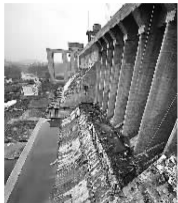
2012年11月10日,南水北调丹江口大坝第14坝段溢流堰面加高工程正在进行。陈华平摄(新华社发)
