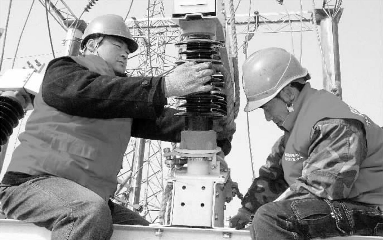
河南省延津县电业局日前对35千伏岳湾变电站进行了增容改造,以提高冬季供电可靠性,确保用电高峰期辖区工矿企业顺利生产。图为变检工区人员冒着严寒在高空作业。 本报通讯员张振民 狄怀法摄影报道
