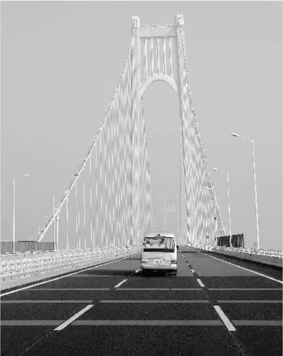
12月24日,南京长江第四大桥正式通车。南京长江四桥项目全长28.996公里,主跨径1418米,是目前国内跨径最大的三跨吊悬索桥,在同类桥型中居世界第三。
