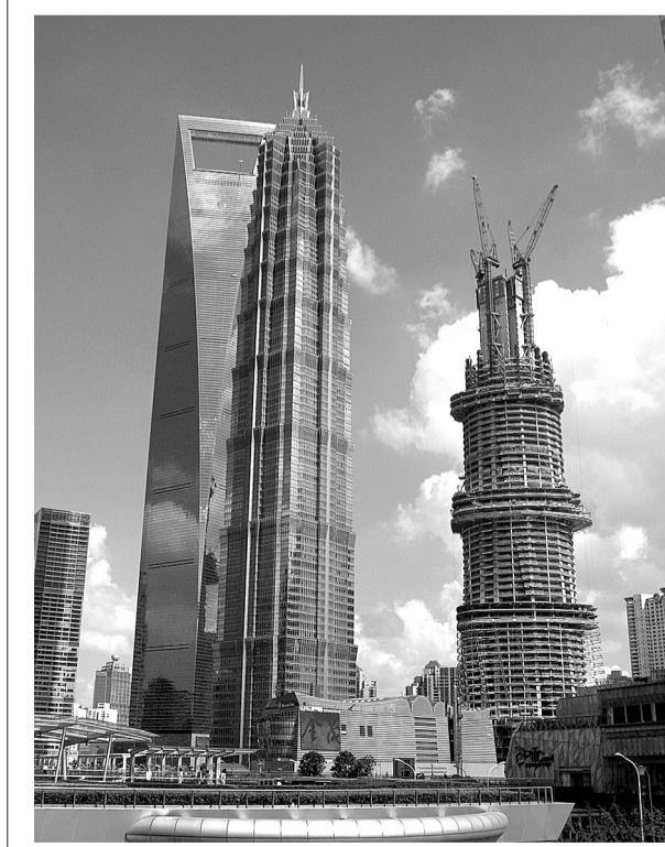
随着主楼核心筒第86层楼板500立方米混凝土浇筑完毕，设计总高度为632米的上海未来新地标“上海中心”成功突破400米，达到403.2米，预计到12月底可达到424米。按照工程总计划，“上海中心”将于2015年全面建成并启用。
