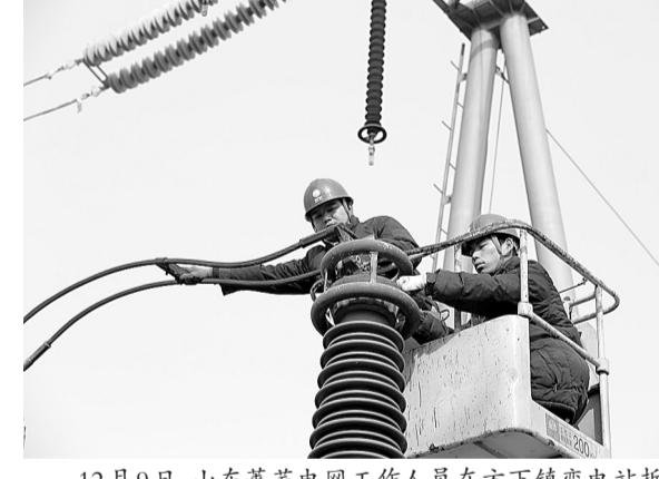
12月9日，山东莱芜电网工作人员在方下镇变电站拆除高频通道的阻波器。2010年起，莱芜电网开始对所辖220千伏线路的保护通道逐步进行光纤化智能电网改造。随着方下镇变电站的改造完成，传统的阻波器彻底退出莱芜电网，当地继电保护通道将更加可靠。 王宪才摄
