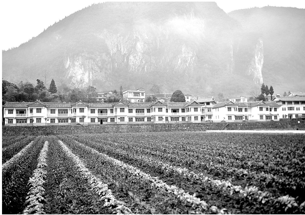
这是12月9日在湖北省恩施土家族苗族自治州宣恩县水田坝村拍摄的即将竣工的特色民居小区。
