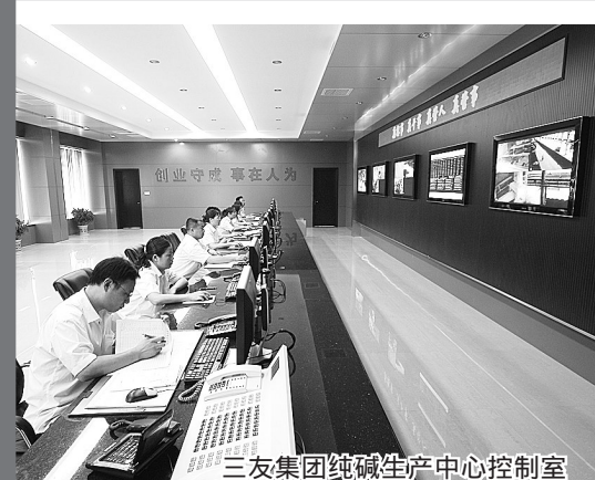
三友集团纯碱生产中心控制室
