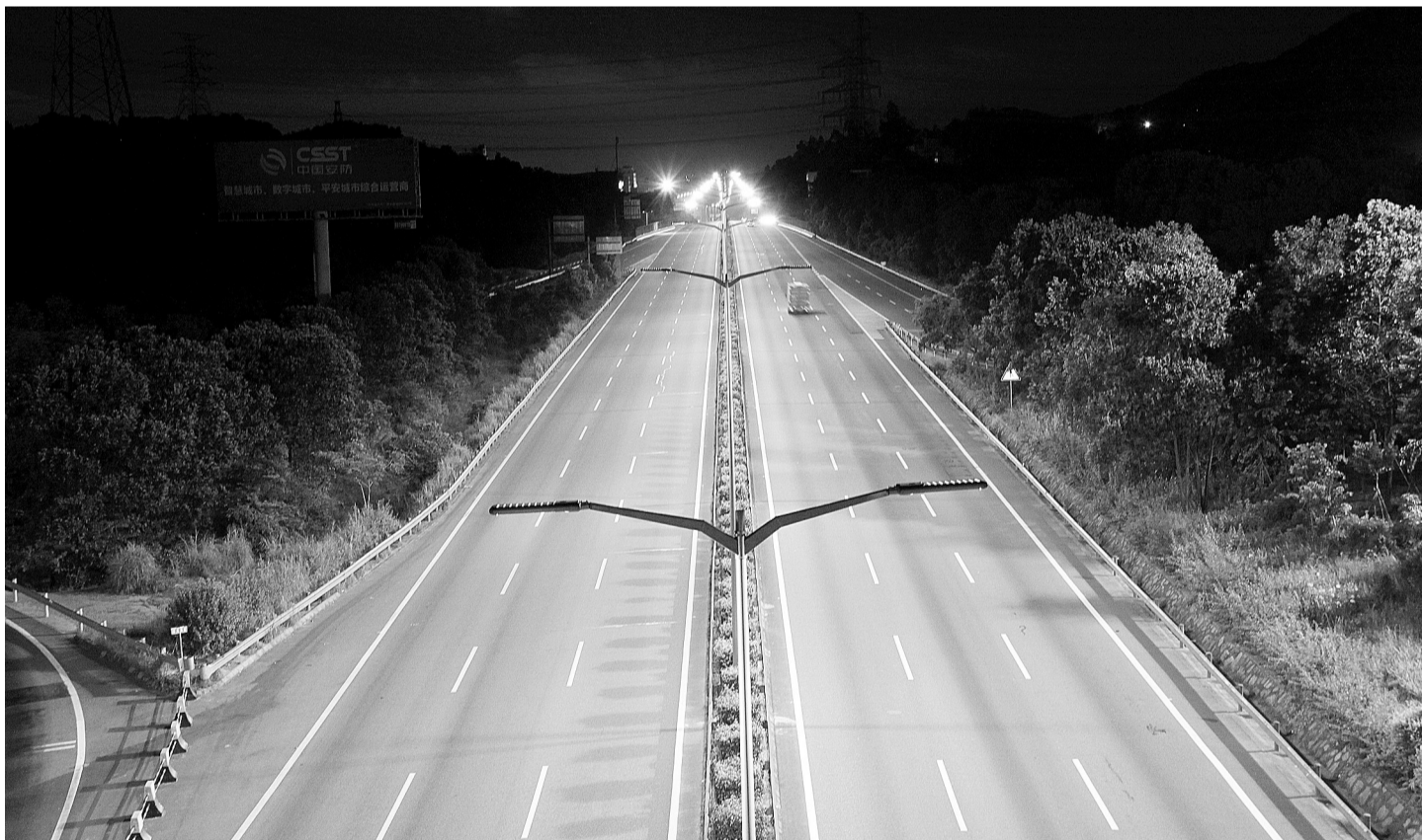
2011年11月，深圳高速公路LED路灯及隧道灯照明工程顺利竣工。这个总长120公里的LED照明项目，是我国第一个大规模应用LED路灯的高速公路项目，打破了LED照明尚不能用于主干道的说法，对LED推广应用具有重要意义。图为深圳高速段的龙大高速。 捷友供图
