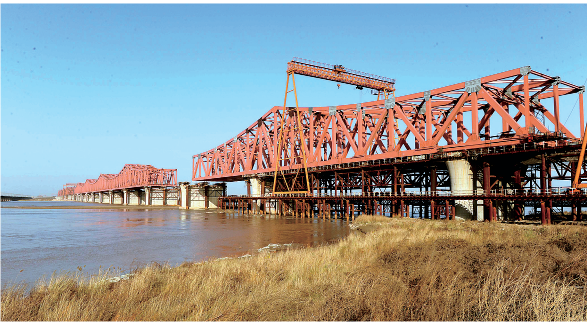
由中铁大桥局建设的河南郑州至焦作铁路客运专线暨改建京广铁路跨越黄河特大型铁路桥工程日前进入桥梁架设阶段。该线铁路桥设计全长9633米,工程计划于2013年底建设完工。
