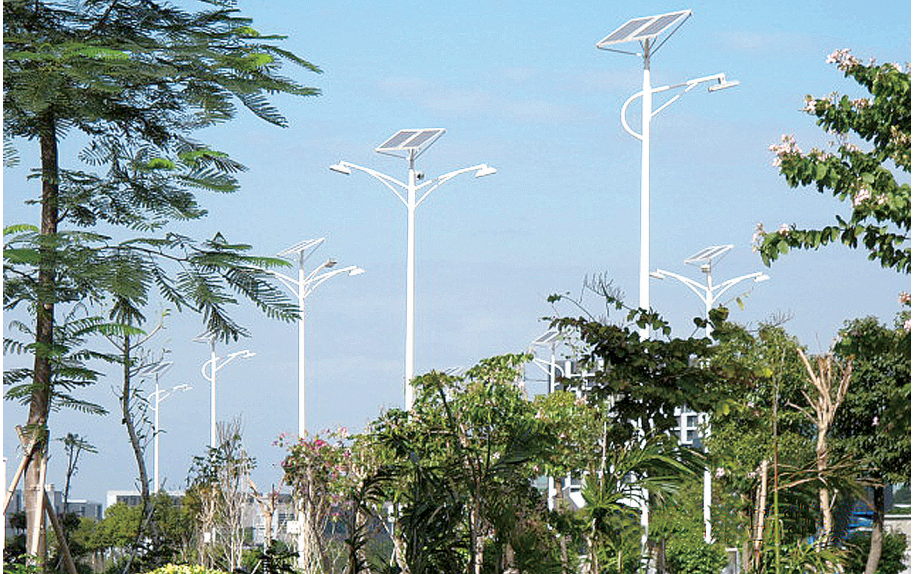
厦门高新区的路灯是用新工艺设计的LED光电互补路灯,与风光互补灯比较,节约近三分之一的投资。
