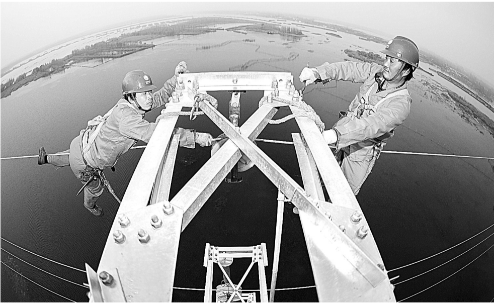
11月21日,电力工人在铁塔上施工。当日,由国家电网山东送变电工程公司承建的跨微山湖区110千伏双回电力线路工程启动,工程全长19.4千米,总投资6092万元,预计2012年12月底完工,工程建成后将进一步提高湖区居民的用电可靠性。新华社记者 范长国摄
