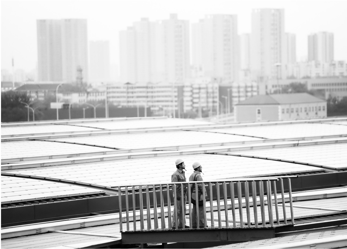
进入测试最后阶段的天津西站光伏电站装机容量为 1884 千瓦 ,是国内最大的建筑屋顶非晶硅并网发电站 ,也是天津市首家实现并网的光伏发电站 ,铺设了总面积 36000 平方米的近 4 万块非晶硅光伏组件。在进入正式商业运行后 ,该站预计年发电量为 200 万千瓦时 ,减少消耗标准煤 700 多吨 ,减少二氧化碳排放量 2000 多吨。图为天津西站光伏电站。 本报记者 牛 瑾摄
