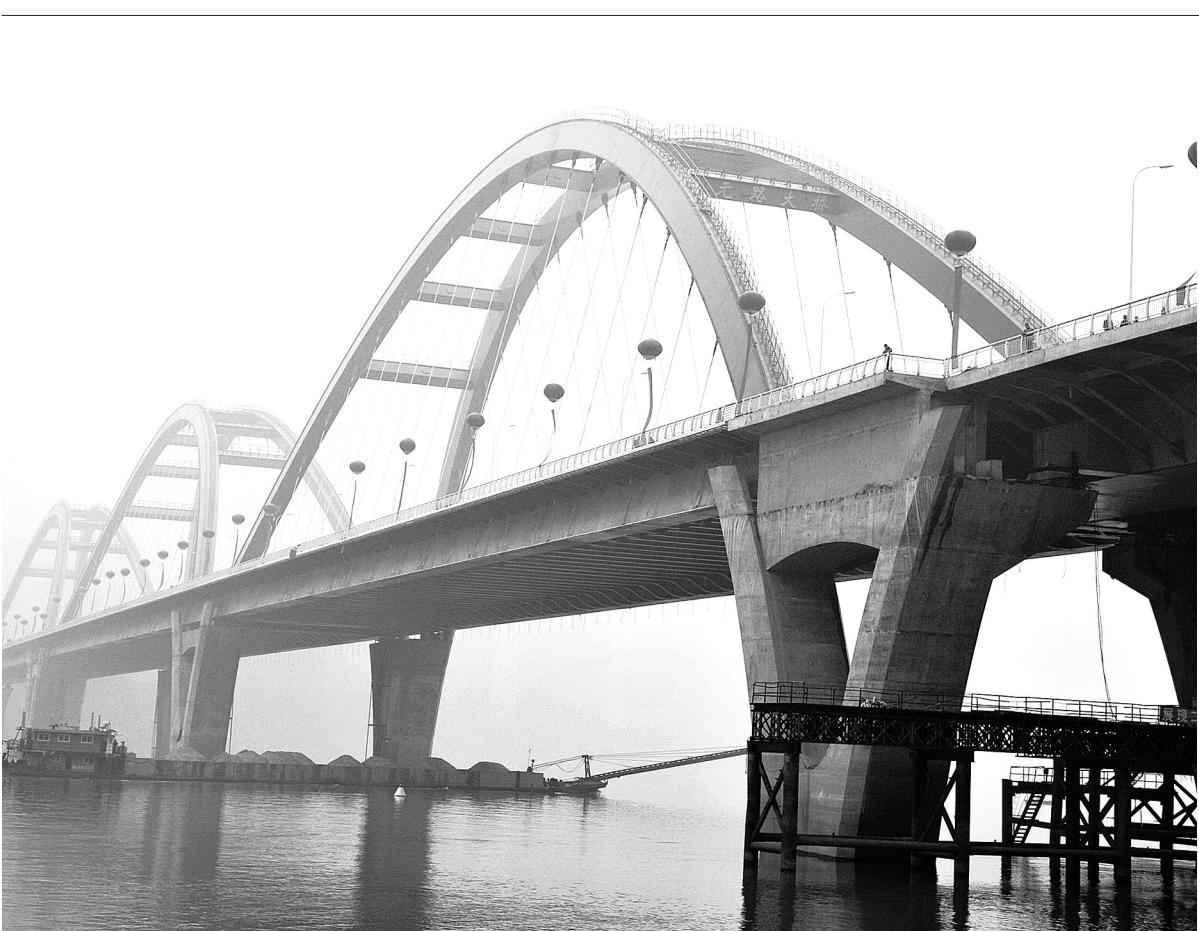
11月20日,湖南长沙福元路湘江大桥正式建成通车。长沙福元路湘江大桥工程线路全长约3.5公里,其中跨越湘江段约1.4公里。大桥的主桥采用3210米提篮式结合梁-钢拱组合结构,六车道设计并设有双向人行道。工程总投资13.85亿元,工期约26个月。
