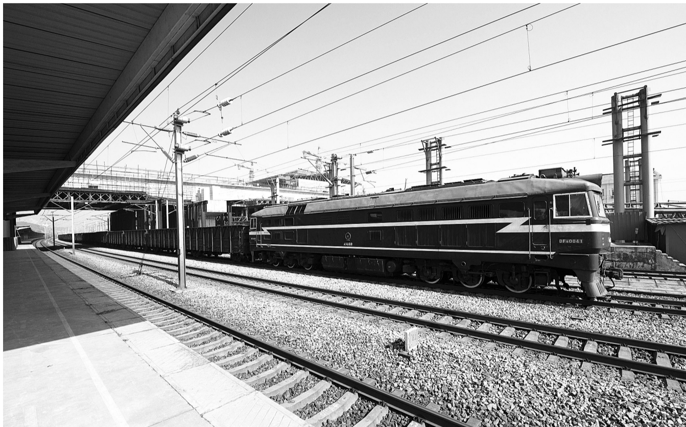
11月18日，一列火车自下穿过四线连续梁，驶过武九线鄂州站。当日，由中铁六局负责施工的武黄城际铁路鄂州站场上跨武九线四线连续梁顺利合龙，标志着武黄城际铁路站台上站工程取得关键性进展。武黄城际铁路与武九铁路在湖北鄂州火车站垂直相交，为最大限度地利用车站空间资源，鄂州站采用在原有武九线火车站上方架设横梁的方式新建城际线站，使两条铁路线立体交叉通行，客运车站上下相通。
