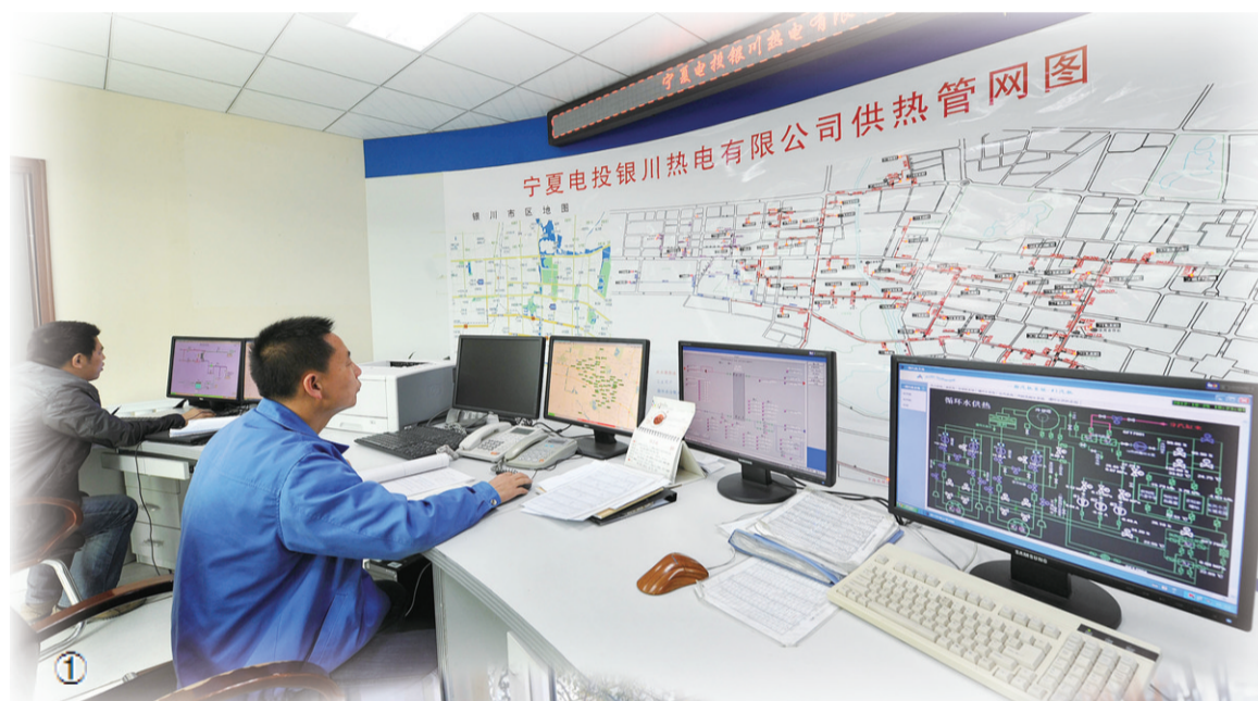
图 10月25日,在宁夏回族自治区银川热电公司控制室内,工作人员在监测区域内的供暖情况。受天气影响,宁夏银川部分供热企业从10月25日开始提前供暖。新华社记者 彭昭之摄
