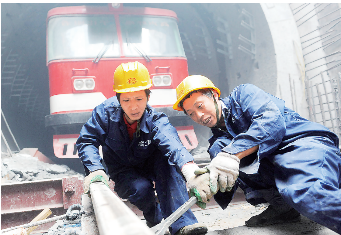
6月30日,北京地铁10号线二期西钓鱼台站工区,工作人员正在拧紧轨道螺栓。当天,北京地铁6号线一期和10号线二期实现轨道贯通,为两条地铁线路年底通车打下基础。 本报记者 赵晶摄
